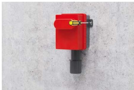
1.Določiti pozicijo ohišja odtoka in ga pritrdirti na grobo steno oz. ga v steno vzdolbsti.
