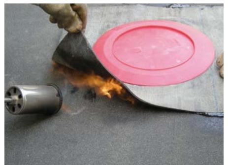
3. Bitumensko obrobo odtoka plamensko spojiti na prvi bitumenski sloj
