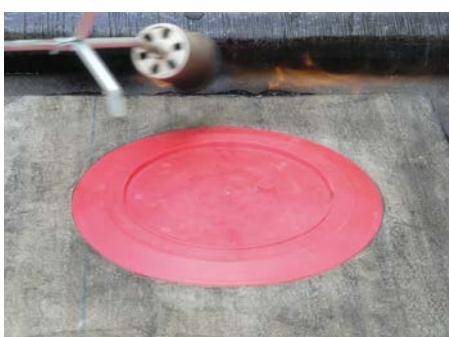
4. Spojiti drugi bitumenski sloj z bitumensko obrobo odtoka
