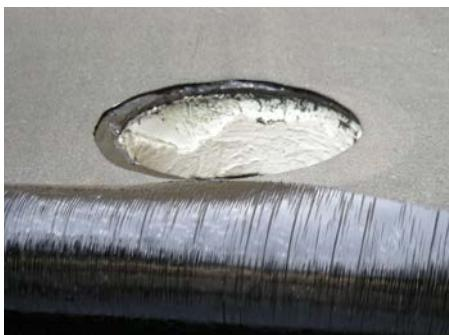
1. Izdelati osrednjo izvrtino Ø 300 mm, nanesti predhodni namaz, položiti prvi bitumenski sloj
