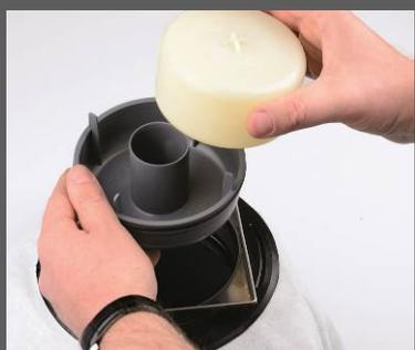
In questa fase tutto è già stato installato anche la copertura piastrellabile con piastrelle da 8mm a 30mm. Il Sistema "Primus" è un così detto "sifone a secco", previene la fuoriuscita di esalazioni anche quando l'acqua nel sifone è evaporata. Naturalmente questo sifone è estraibile ed ispezionabile, quindi doppio vantaggio, facile pulizia e generoso accesso al tubo di scarico nel caso in cui si verifichi un intasamento. La sicurezza è importante!
