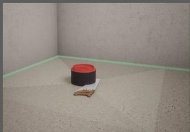
Questo passaggio è molto semplice perchè: il massetto è già stato completato, comprese le pendenze, ma senza preoccuparsi dell'altezza. Non è necessario posizionare lo scarico alla stessa altezza del massetto come un comune corpo di scarico poichè rimane sempre una parte in eccedenza che si può tagliare con una sega o con un flessibile appena il massetto si è asciugato.
