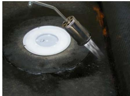
2. Piekausēt trapa hidroizolācijas loksni pie pirmā hidroizolācijas slāņa. Otrs hidroizolācijas slānis piekausējams uz virsmas (līdz stiprinājuma atlokam).
