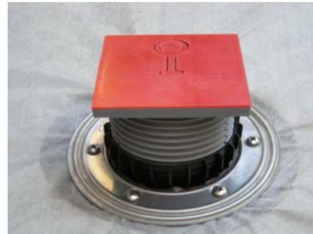
5. Filtrējošais slānis saspiežams starp hidroizolācijas gredzenu (HL83.0) un uzstādāmo elementu (HL85N), uzstādāms drenāžas gredzens (HL180), kurā ievietojams trapa uzstādāmajais elements, saīsināts saskanā ar galīgo jumta seguma virsmas līmeni. Augšā uzstādāms montāžas korķis.
