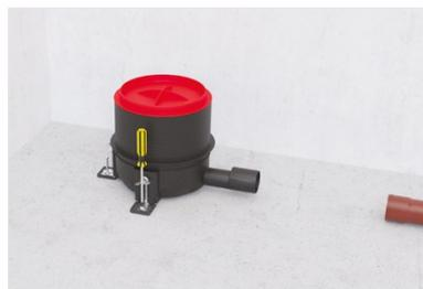
5. Ablaufkörper mittels Befestigungswinkeln an die Rohdecke fixieren.
