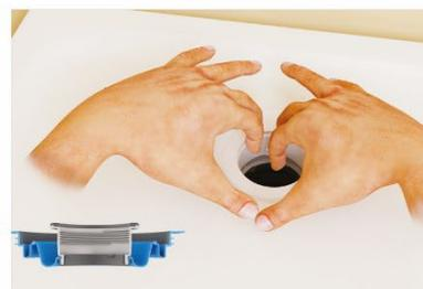
15. Den unteren Ring des Flex-Elements auf den Ventilteller aufziehen und damit Ablauf und Duschtasse dicht miteinander verbinden. Montageschlüssel/Bauschutz in die Ablauföffnung einsetzen. Anschließend: Dichtheitsprobe!
