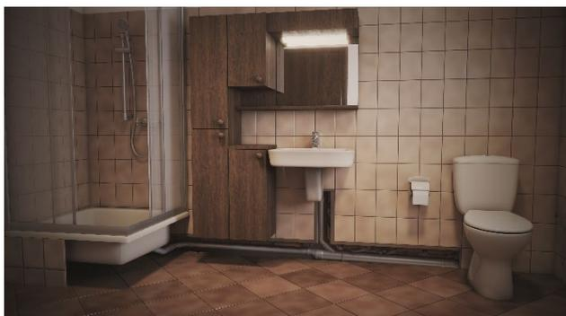
Das in die Jahre gekommene Bad mit erhöhter Duschwanne. Im Untergrund sichtbar gemacht der Verlauf der alten Abwasserleitung
