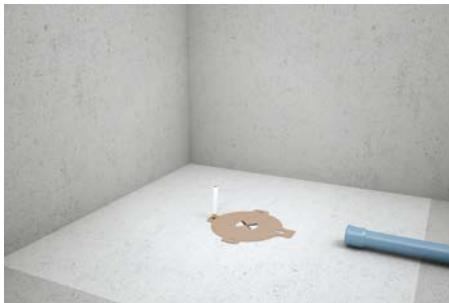
1. Odrediti poziciju sливника, postaviti montažnu šablonu u pravcu odvodne cijevi i obilježiti rupe za bušenje.
