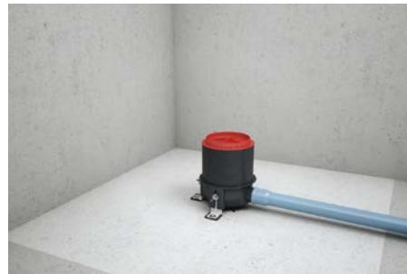
3. Postaviti sливник, pričvrstiti ga pomoću pričvrsnih nosača na betonsku konstrukciju i spojiti sa odvodnom instalacijom.
