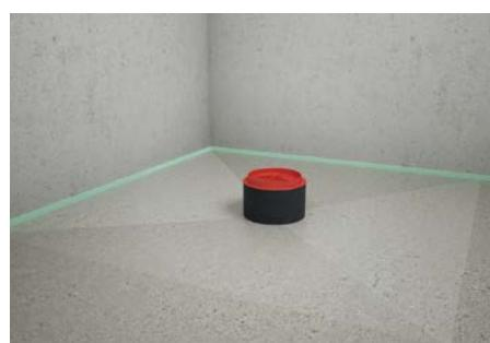
5. Ispuniti cementnu košuljicu u tuš-prostoru sa minimalnim padom od 2%.
