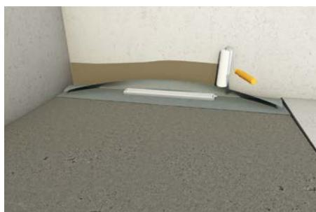
7. Premazivanje zida hidroizolacijom i spajanje folije kanalice sa izolacijom obostrano
