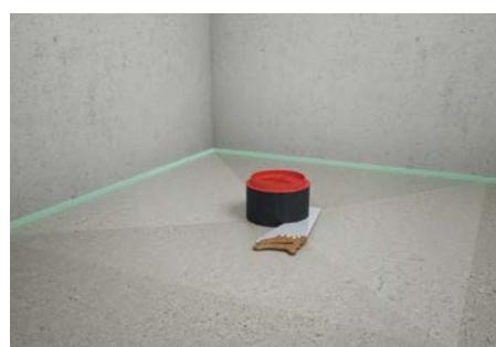
6. Cijevni dio sливnika koji je ostao iznad površine cementne košuljice potrebno je skratiti ravno sa površinom cementne košuljice.
