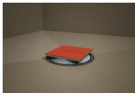
9. Postaviti završni okvir sa građevinskom zaštitom u sливnik te, ukoliko je potrebno, skratiti nastavak.
