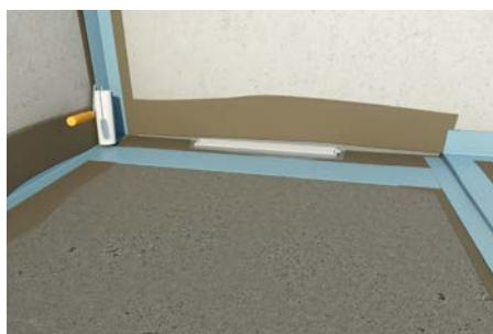
8. Po rubovima i prelazima postaviti fleksibilnu izolacijsku traku kako bi se premostile pukotine i cijeli tuš prostor premazati sa hidroizolacijom.
