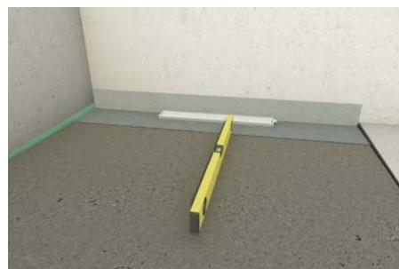
6. Izljevanje cementne košuljice (estriha) sa najmanje 2% pada od ruba tuša prema tuš kanalici.
