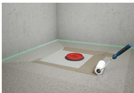
8. Nanijeti premaz hidroizolacije preko kompletног tuš-prostora i osigurati sve prelaze brtvenim trakama zbog premošćivanja pukotina. Obostrano premazati brtvenu prirubnicu hidroizolacijom.
