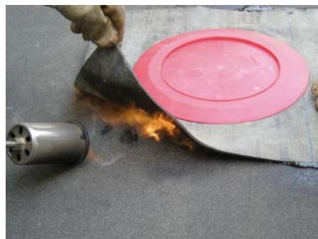
3. Zavariti bitumensku prirubnicu slivnika na prvi sloj bitumenske trake
