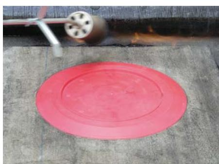
4. Zavariti drugi sloj bitumenske trake sa bitumenskom prirubnicom slivnika
