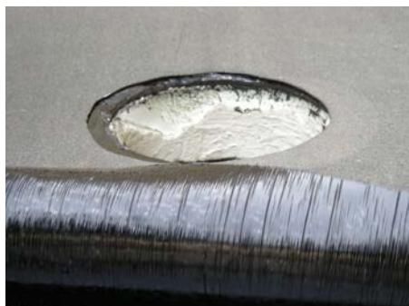
1. Izbušiti rupu kroz ploču Ø 300 mm, nanijeti premaz, postaviti prvi sloj bitumenske trake
