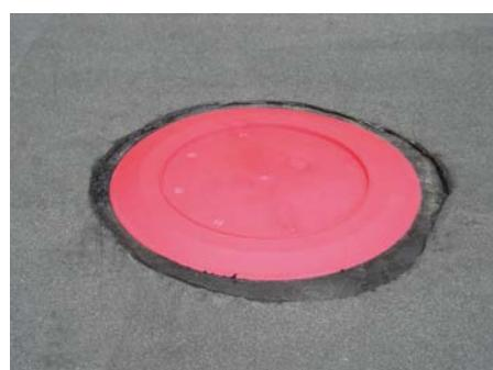
5. Završetak spajanja slivnika u dvoslojnu bitumensku hidroizolaciju
