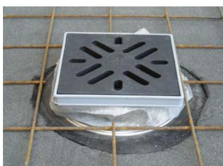
7. Omotati nastavni element geotekstilom i postaviti armaturu
